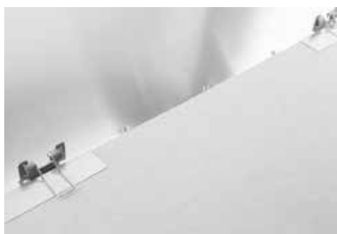
GK-Montage mit SNAP-IN Federeinbausatz
