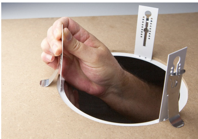
Abb. 4 Spannen der Klammern
